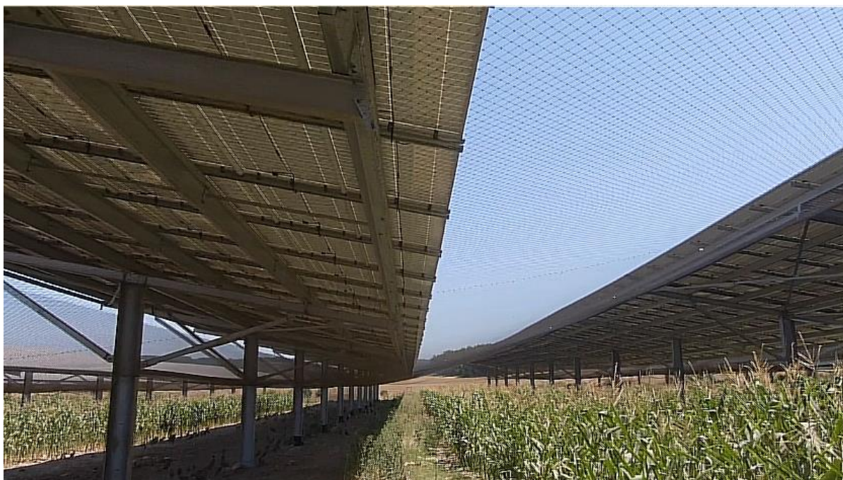
Figure 7 : Photographie d'une volière agrivoltaïque développée par Technique Solaire avec l'aménagement du parcours extérieur avec des rangs de maïs permettant la conservation du comportement de dissimulation des oiseaux lors de leur vieillissement.
